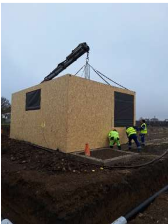
Dovoz a osádzanie kontajnerov
