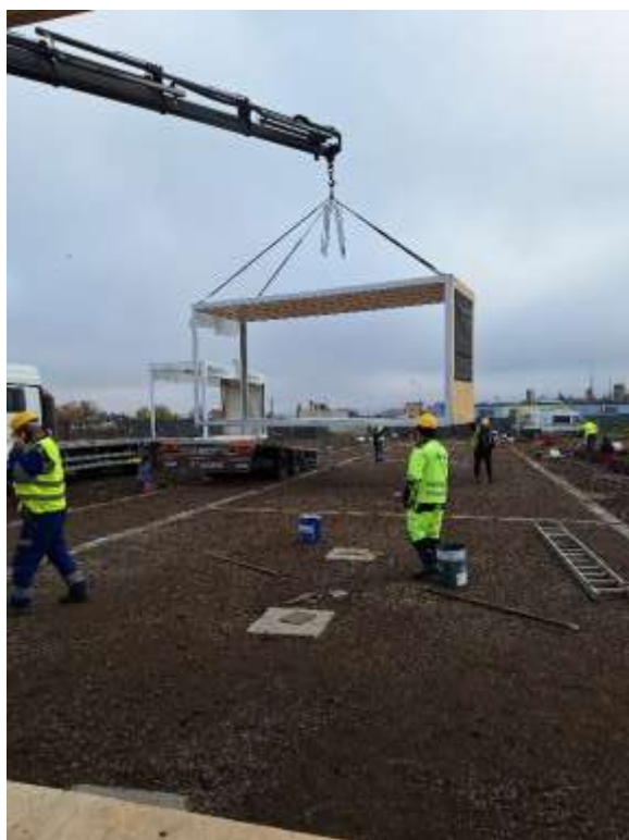
Dovoz a osádzanie kontajnerov
