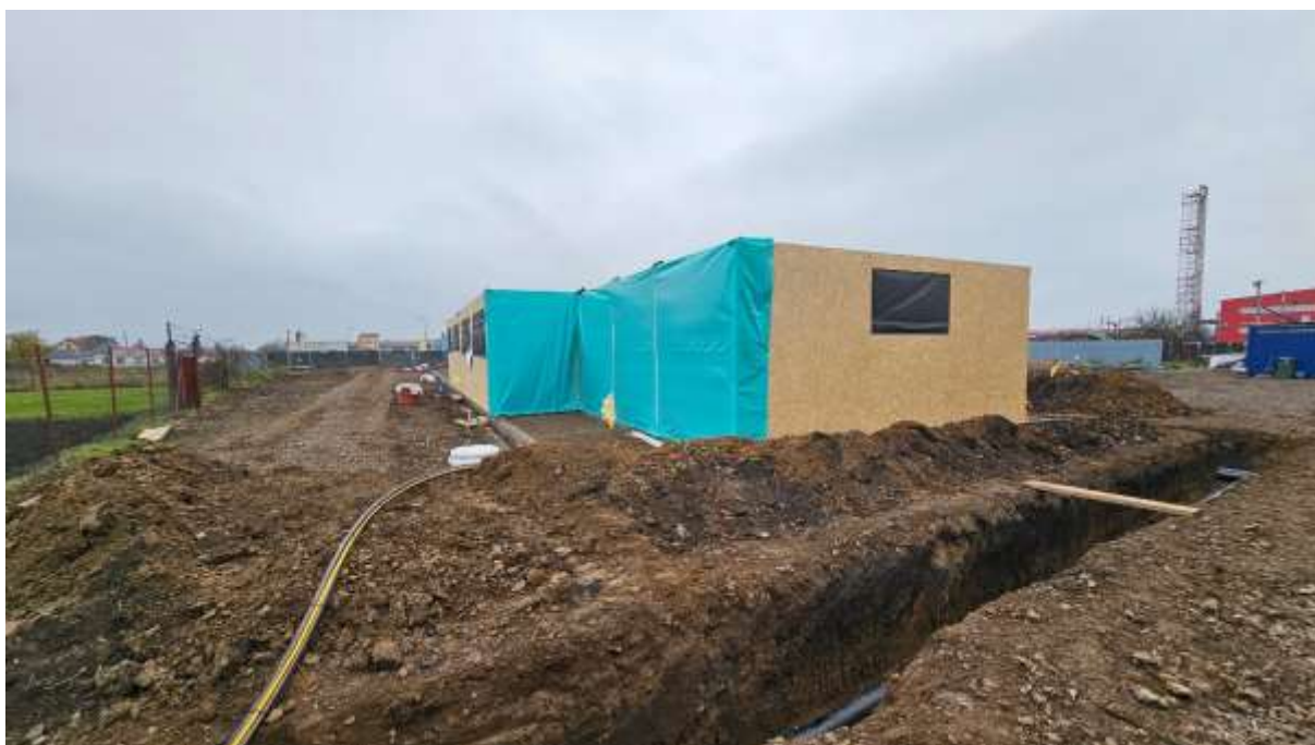
Časť osadených kontajnerových modulov
